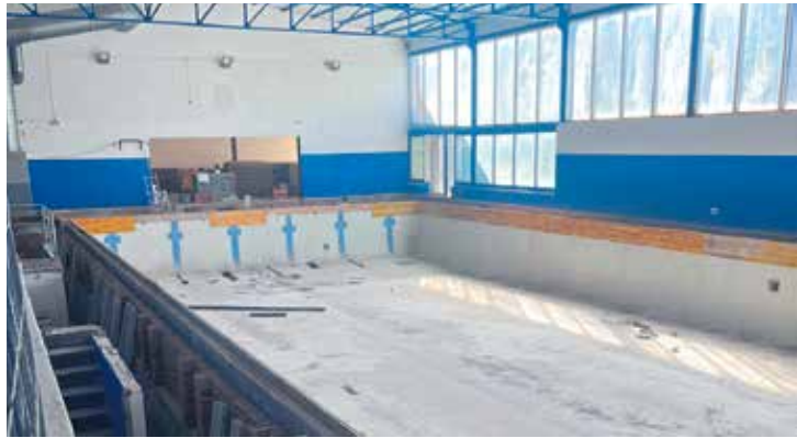
L'estat actual de les obres a la piscina antiga de Les Cremades. > CEDIDA
