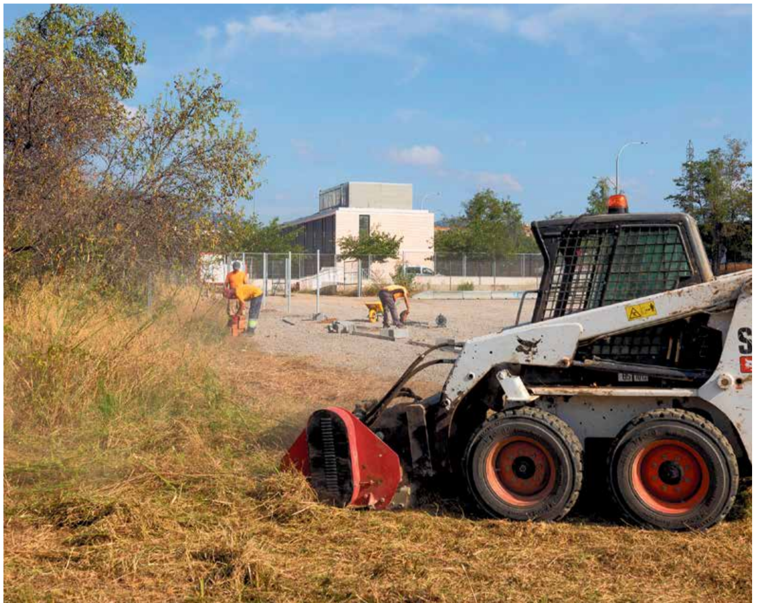
Operaris en els primers treballs d'arrencada del projecte de construcció del nou edifici que ocuparà l'Institut Escola de Caldes de Montbui. > J. SERRA
